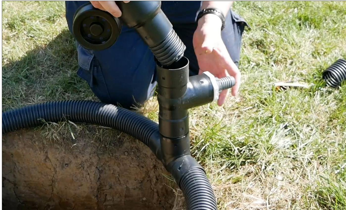
Automatische Bewässerung ist eine beliebte Methode zur Senkung der Pflegekosten für Bäume und andere Pflanzen. Der RootRain Auto-Irrigationsadapter ist mit allen RootRain-Bewässerungssystemen mit 60 mm Durchmesser kompatibel und bietet eine robuste, mit Widerhaken versehene Steckverbindung zur einfachen Anbindung an eine bestehende automatische Wasserzuleitung.
